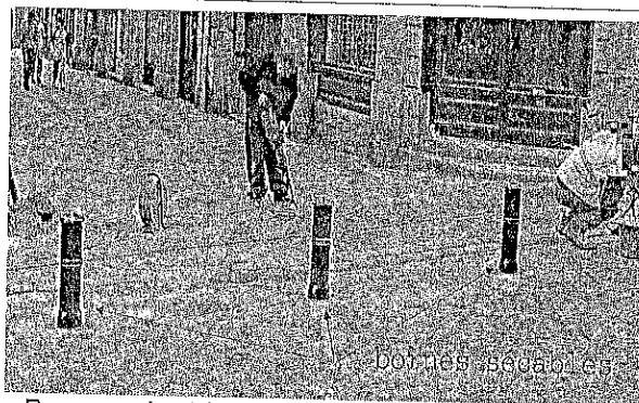
Bornes sécables par un homme sur poussée
